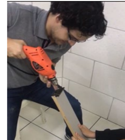
Mão na massa – fixação de cavaletes
